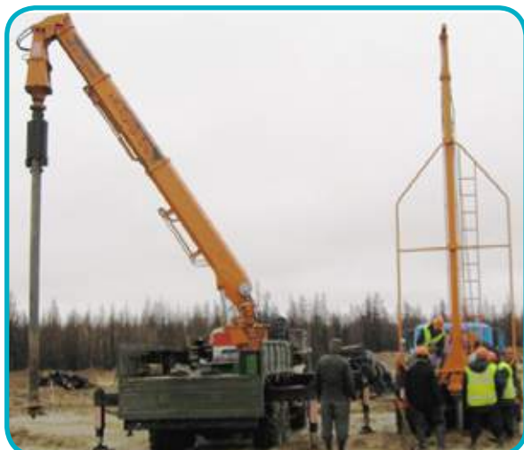
Рис. 5. Универсальная бурильная машина УБМ-85 и бурильно-крановая машина БКМ-515 на свайных работах в Новом Уренгое по устройству фундаментов из стальных винтовых свай в ММГ (06.2007)
