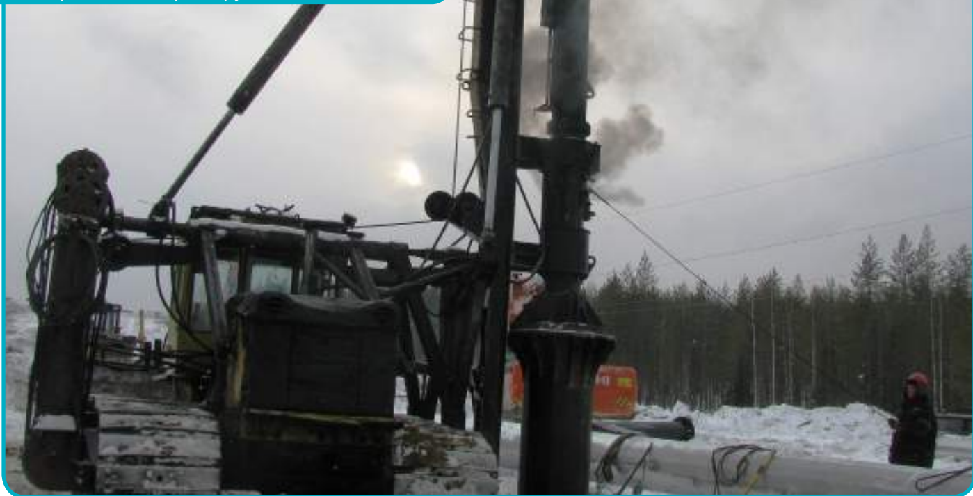
Рис. 2. Отечественный сваебойный агрегат СП-49А с дизель-молотом типа СП-76 для вертикальных и наклонных свай, ударно погружающий стальную сваю-оболочку диаметром 0,8 м на глубину 8,0 м через «подбабок» на строящейся ВЛ 220 кВ «Печорская ГРЭС – Ухта» (2013), в качестве альтернативы вибропогружаемой технологии
