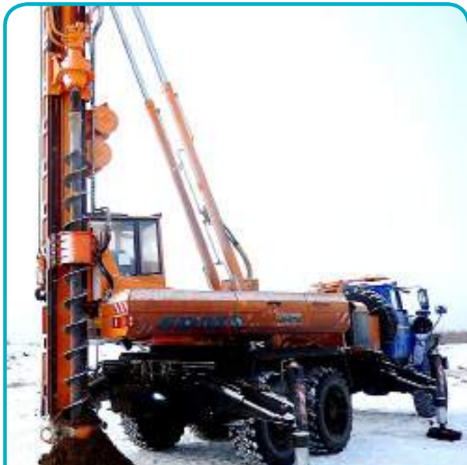
Рис. 3. Бурильно-сваебойная машина БМ-811М: эффективное бурение лидерных скважин на глубину 15м перед завинчиванием винтовых свай (переход ВЛ 220 кВ через р.Печора в Республике Коми; фото: 03.2014)
