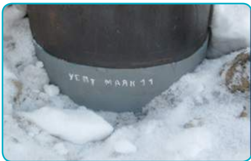
Рис.1. Противопучинная оболочка ОСПТ «Reline» на свайной конструкции
